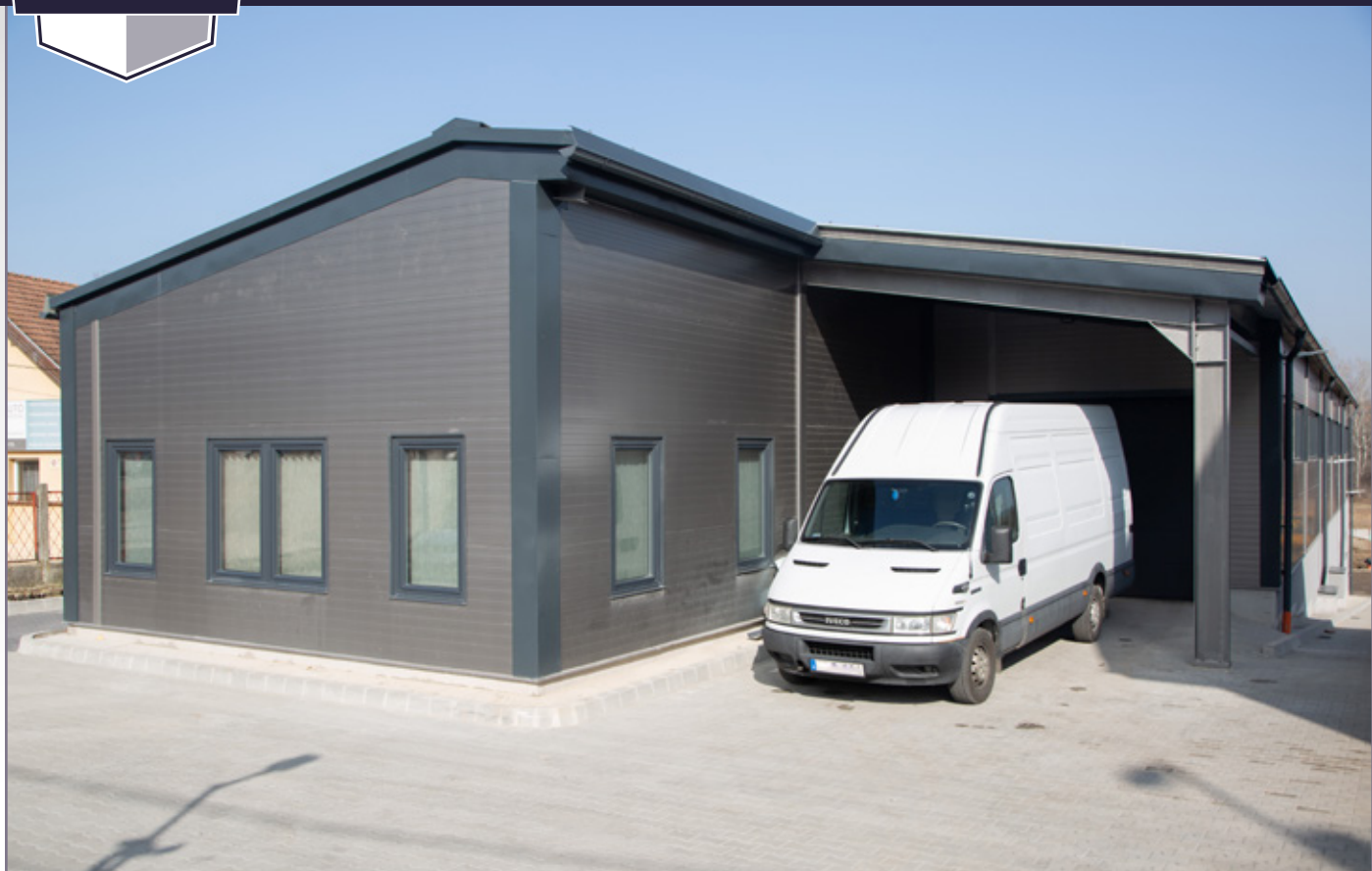
Restaurare birouri si sala atelier 12 m x 45 m x 4,5 m | Locul constructiei: Pécel
