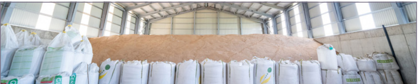
Hambar de cereale cu acoperis in fata | Locul constructiei: Medgyesegyháza
