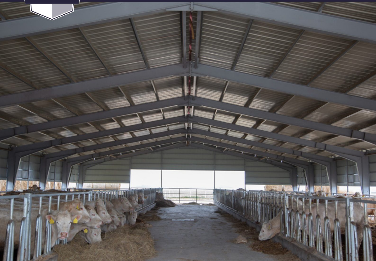
20 m x 48 m x 4 m nyitott istállóépület, válogató karámrendszerrel | Megvalósulás helye: Pusztaföldvár
