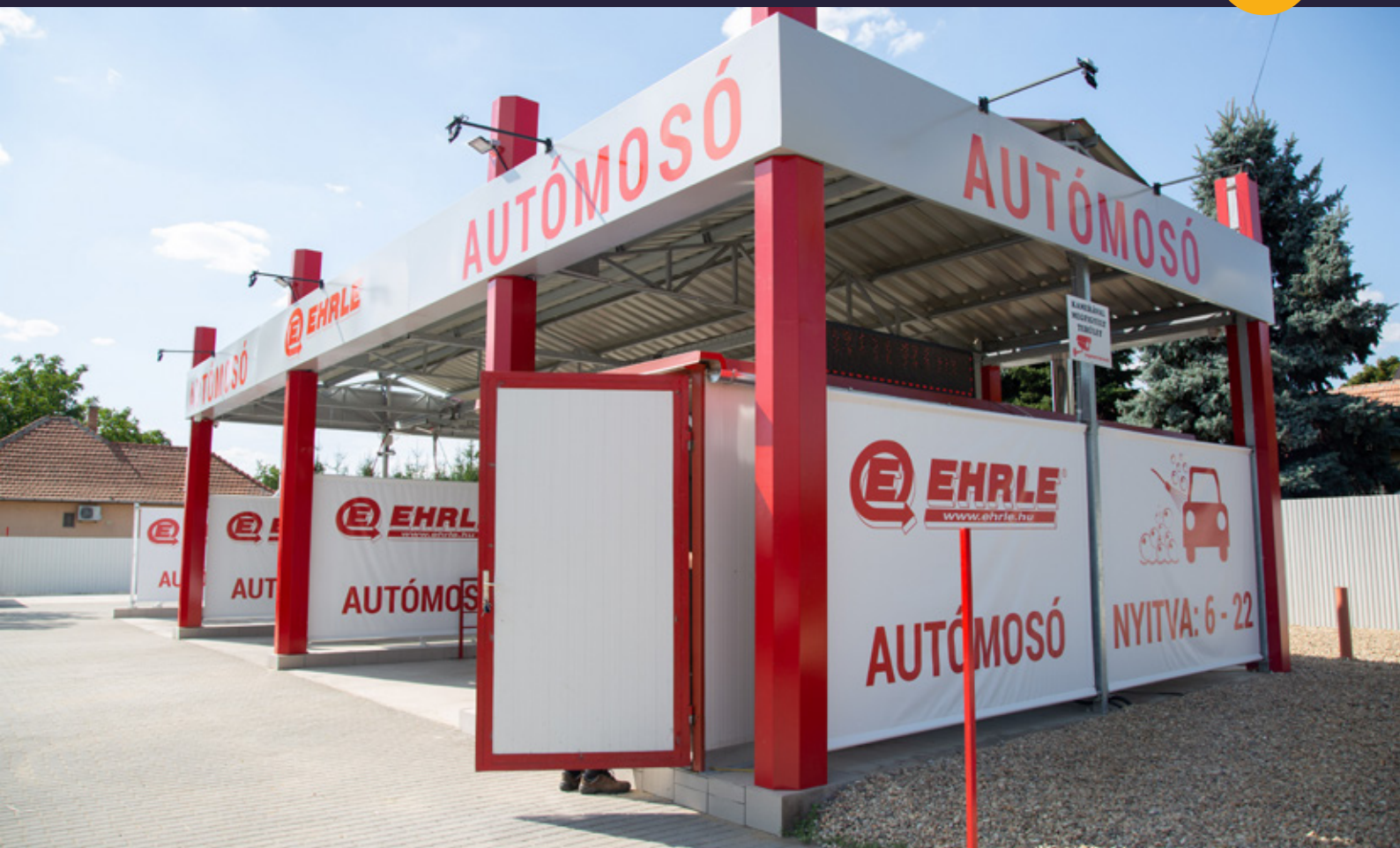
3 állásos, könnyűszerkezetes autómosó épület | Megvalósulás helye: Heves
