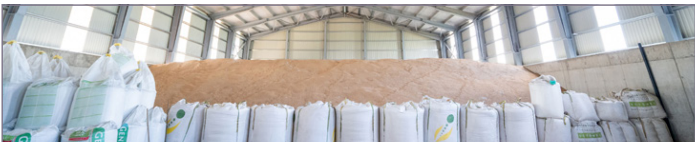
Terménytároló csarnok előtetővel | Megvalósulás helye: Medgyesegyháza
